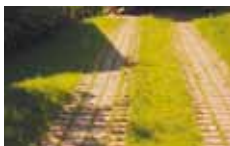
Gepflasterte, nicht an Kanalisation angeschlossene Bodenschicht
