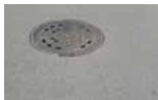
Asphalt oder Beton
