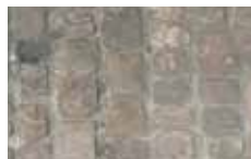
Steinbelag mit Fugenverguss
